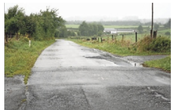
Am kommenden Montag beginnen in Holzheim die Straßenbauarbeiten. Foto: Arno Colaris
